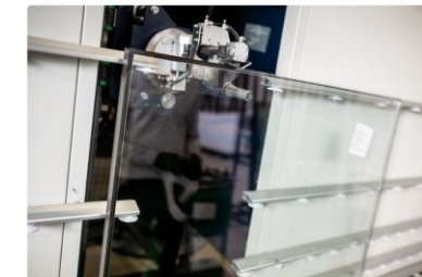
6. Nieuwe ruit isoleren
