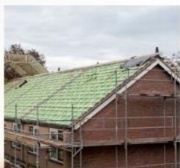
Foto's van originele constructie
